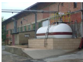
Резервоар за прием на концентрирана H_2SO_4 - после реконструкција
